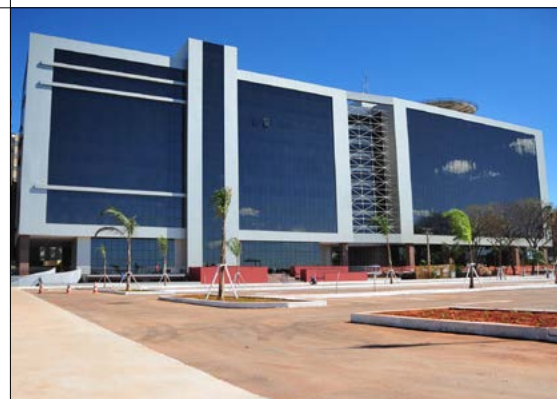
Ampliação do Edifício-Sede do MPDFT, com a construção da 2ª Etapa
