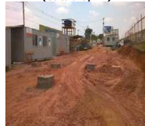
Passarela nº 7 (EPCL) – estacas de fundação (outubro/17)
