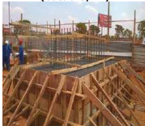
Passarela nº 6 (EPCL) – forma e armação de blocos (outubro/17)
