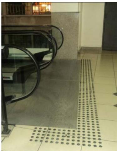
Figura 1.20 | Piso táctil de direcionamento
