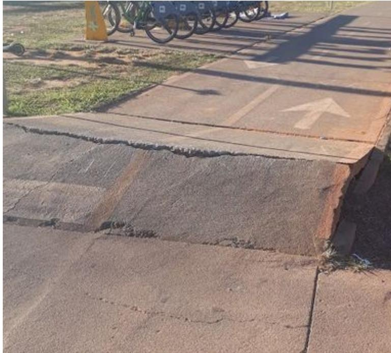
***Pavimento de asfalto completamente destruído nesse trecho pela dilatação térmica.***
