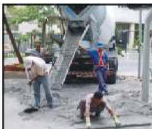
Lançamento, espalhamento e nivelamento (sarrafeamento) do concreto.
