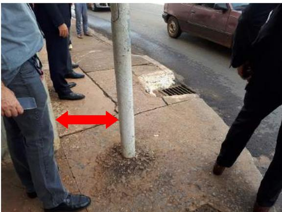
Imagem 47 – Vista de calçada estrangulada por poste e bueiro na esquina da desembocadura da pista sul do Eixo Rodoviário;
