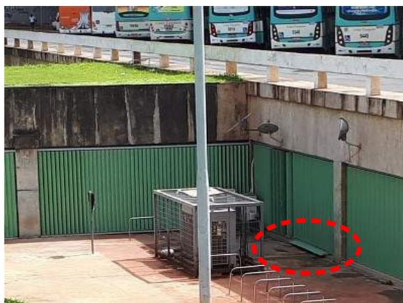
Imagem 203 – Detalhe de peça do brise retirada do lugar para promover acesso irregular à área externa;
