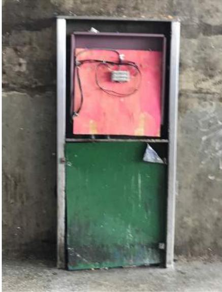
Imagem 226 – Vista de quadro de energia ou telefonia sem tampa, com fiação exposta;
