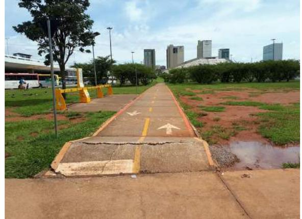
*Imagem 86 – Idem Imagem 85. Detalhe de piso destruído na ciclovia;*
