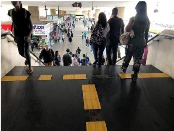
*Imagem 121 – Detalhe de falha da sinalização podotátil próximo à escada;*
