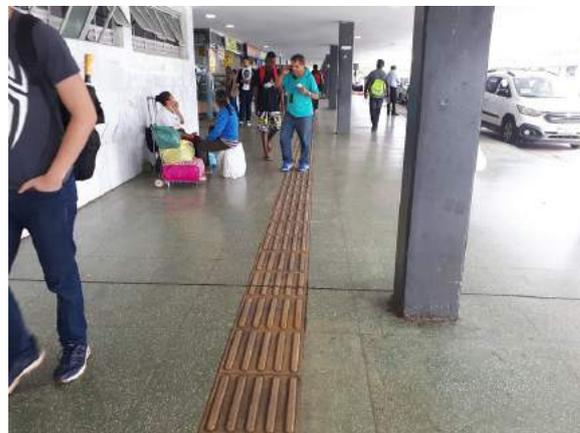
Imagem 14 – Detalhe de piso tátil direcional em um dos acessos. Note-se que o obstáculo (pilar metálico) não está sinalizado;
