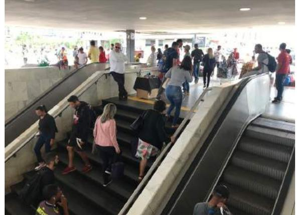
Imagem 138 – Detalhe da chegada da escada na plataforma superior: corrimão irregular;
