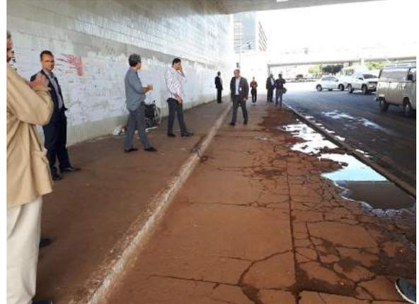
Imagem 44 – Vista da calçada sob a plataforma, com pavimento quebrado, acúmulo de água e dois níveis diferentes;
