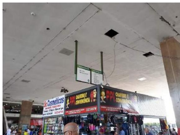
Imagem 209 – Vista de fiação elétrica exposta e buracos abertos na laje;
