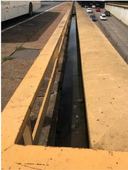
*Imagem 216 – Condições precárias de manutenção na área externa. Calhas entupidas e sujas;*
