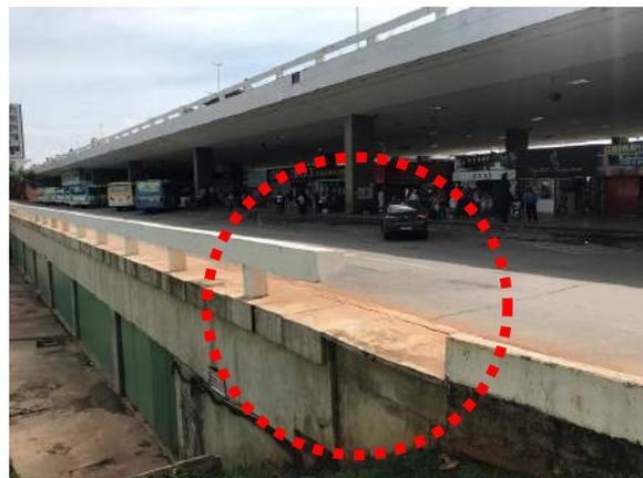
*Imagem 215 – Idem Imagem 214. Além do aspecto da conservação há risco de queda para pedestres, pela interrupção do guarda-corpo;*
