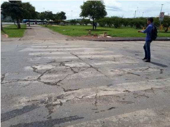
*Imagem 81 – Detalhe do estado de conservação do asfalto na travessia ao lado da ciclofaixa, sem continuidade da pintura no chão;*
