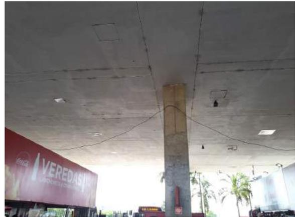
*Imagem 225 – Detalhe da fiação exposta pendurada no pilar da edificação;*
