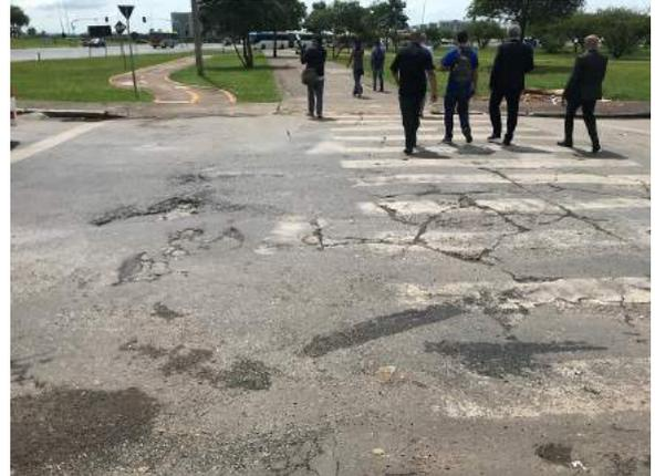
*Imagem 38 – Detalhe do asfalto comprometido e faixa desgastada na travessia da entrada nordeste da Rodoviária;*
