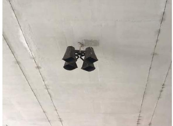
Imagem 227 – Detalhe de dispositivo sonoro de alarme instalado sob a laje da plataforma. Não foram obtidas informações sobre seu funcionamento;
