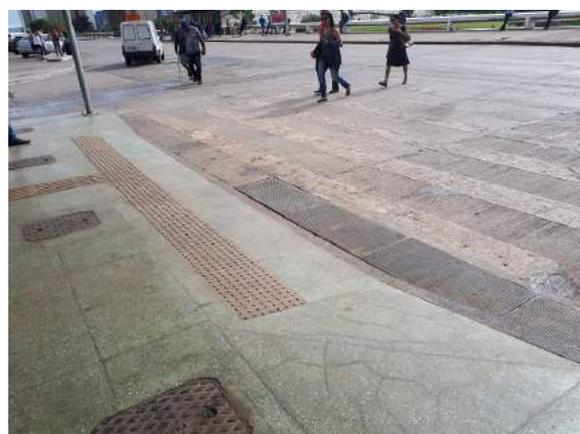
*Imagem 12 – Detalhe da guia rebaixada na*
