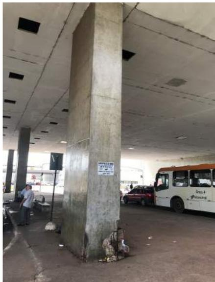
*Imagem 212 – Vista de pilar de concreto com ferragens expostas e oxidadas;*
