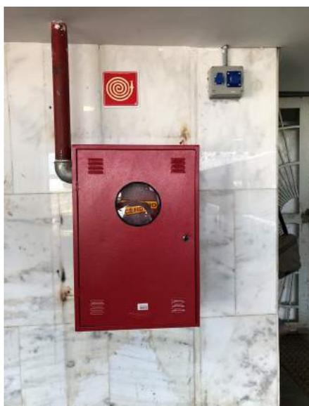
*Imagem 232 – Vista hidrante sem mangueira e vidro de proteção quebrado;*
