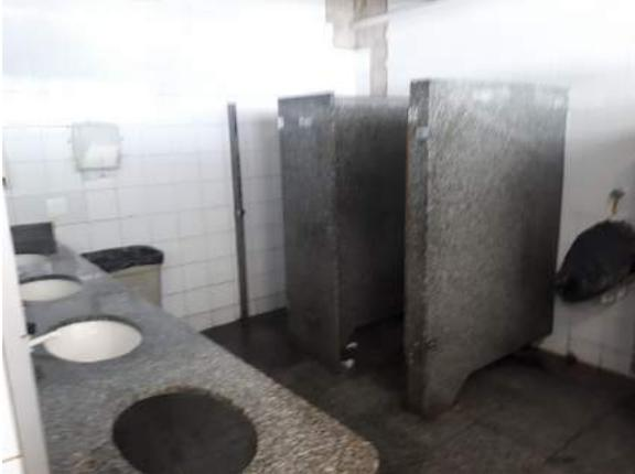
*Imagem 155 – Vista de interior de WC sem cuba no lavatório e mictório desativado;*
