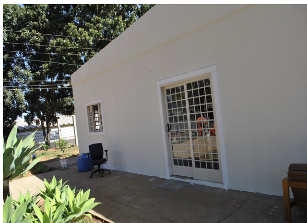
Entrada do bloco 5.
