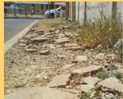
Calçadas despedaçadas são obstáculos para todos
