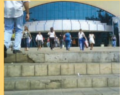
Degraus grandes e falta de rampas dificultam a circulação
