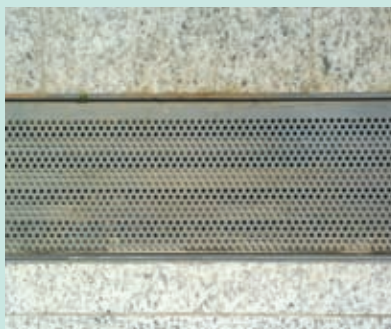
Grades de escoamento devem ter orifícios pequenos
