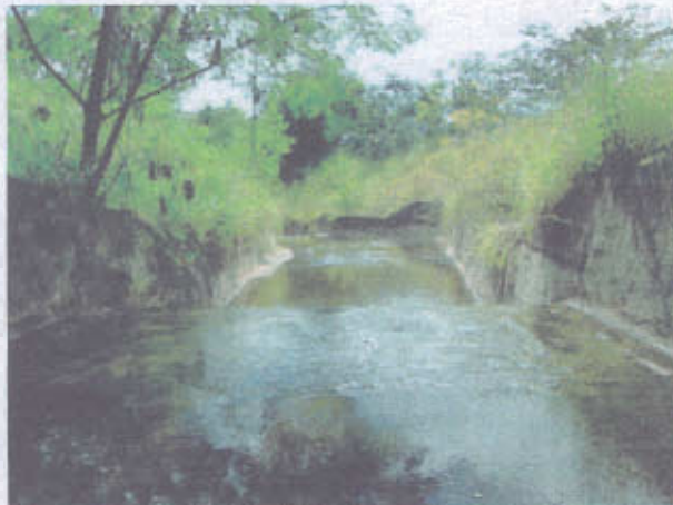
Figura 3 – Canal Aberto de Concreto
