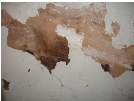
Foto 11: UBS Bosque 2 – paredes mofadas
