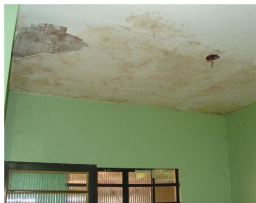
Foto 22: UBS Vila Estrutural – teto mofado
