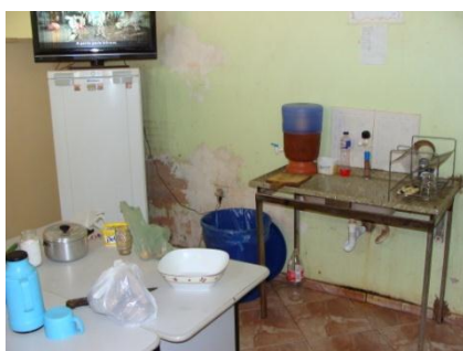
Foto 23: UBS Vila Estrutural – copa/cozinha improvisada
