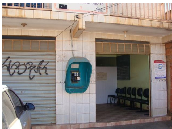
Foto 21: UBS Vila Estrutural UBS Galpão
