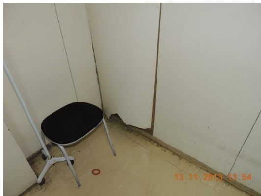
Fotos 21,22,23 e 24: Hospital de Base do DF - buracos e revestimento inadequado na cobaltoterapia
