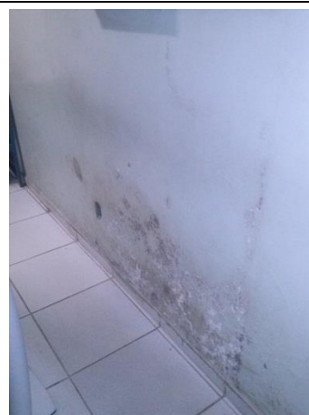
Foto 33 e 34: Hospital Regional de Ceilndia – material inapropriado junto ao tomgrafo e infiltrao na sala do RX fixo
