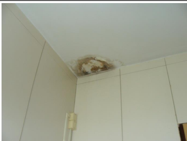
Foto 27: Central Radiológica de Taguatinga - infiltração
