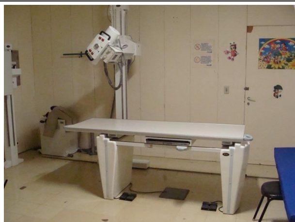
Foto 28: Hospital Regional de Brazlândia - piso e paredes inadequadas na sala do RX
