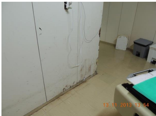
Fotos 21,22,23 e 24: Hospital de Base do DF - buracos e revestimento inadequado na cobaltoterapia
