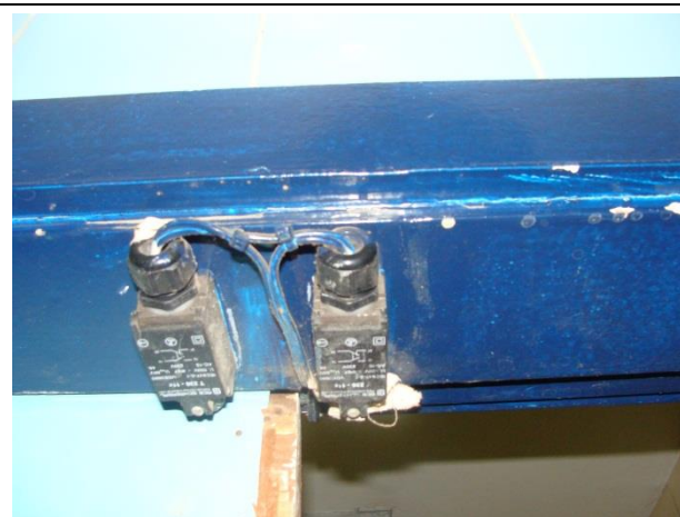
Fotos 29 e 30: Hospital Regional de Planaltina – dispositivos de segurança da porta e sala do RX fixo inadequados
