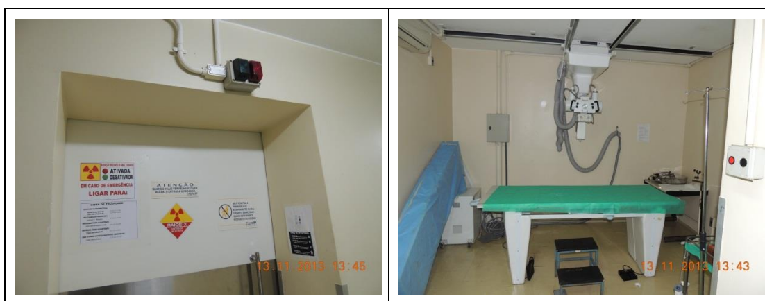
Fotos 03 e 04: Bunker da Radioterapia do Hospital de Base do DF para colocação do aparelho de braquiterapia
